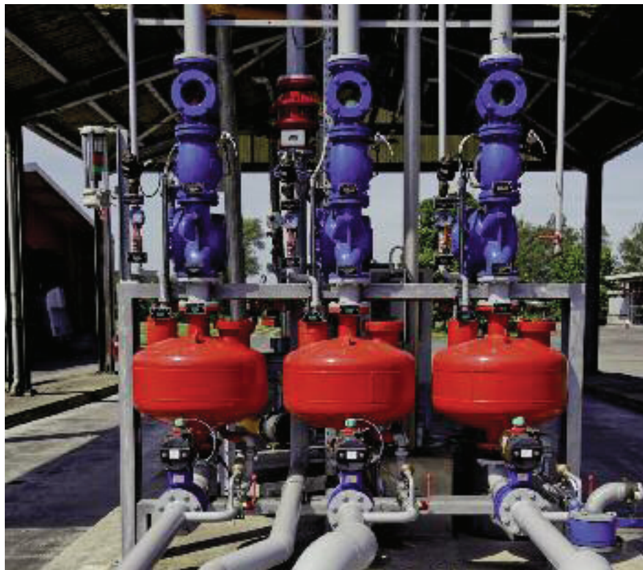
Zur Einhaltung der neuen Luftreinhalteverordnung wurden die Abfüllstationen für Bahn- und Strassenzisternenwagen mit einer Gasrückführung ausgestattet.
